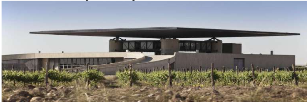
Figura 15. Bodega O’Fournier. Acceso frontal
