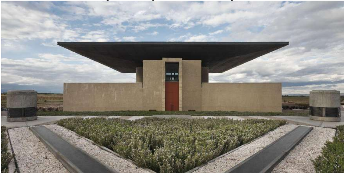
Figura 16. Bodega O’Fournier. Fachada posterior
