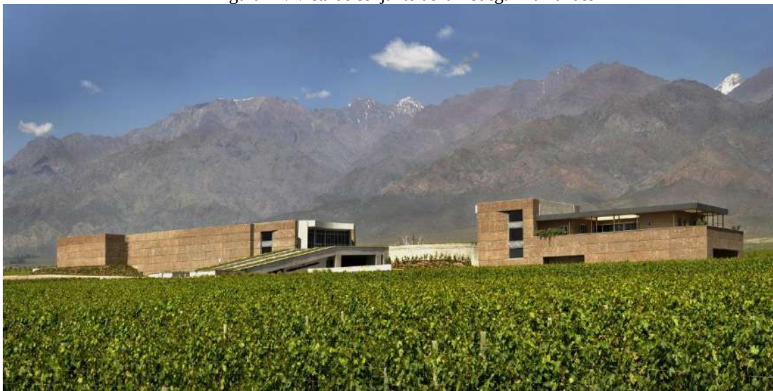
Figura 17. Vista de conjunto de la Bodega Diamandes
