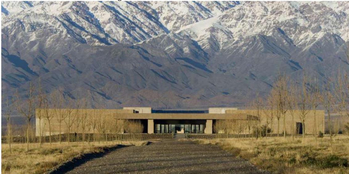
Figura 10. Edificio Kilka. Vista del acceso.
